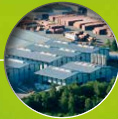
1998 Relocation of technoplant Kunststofftechnik GmbH to Emstek
